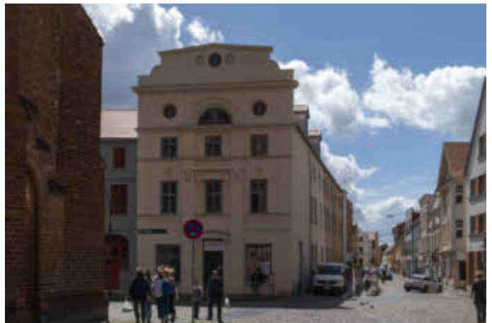
Foto: Baumaßnahme Markt 28
