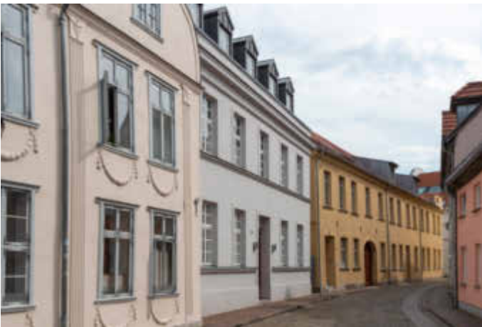
Sanierter Straßenzug in der Kerstingstraße
