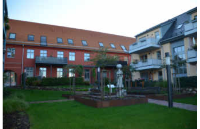
Sanierung des Langhauses Pferdemarkt 45 im Rahmen der Neuentwicklung des Klosterhofes zu einem Wohnquartier mit Freiraumgestaltung
